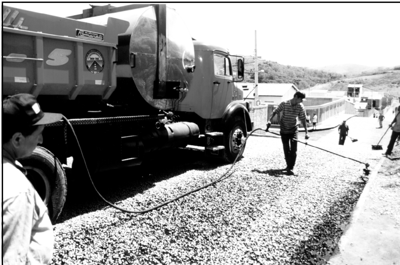
Equipe da Petrobrás aplicando a pavimentação asfáltica no bairro Spalla 2
