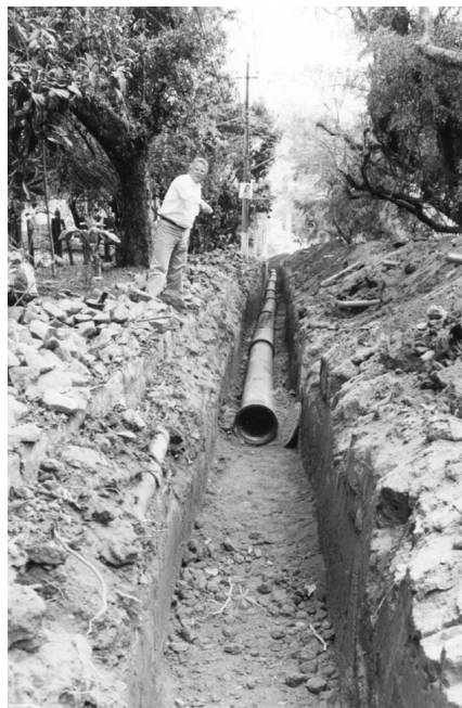
Prefeito Luiz Antônio acompanha as obras no alto da Aparecida
