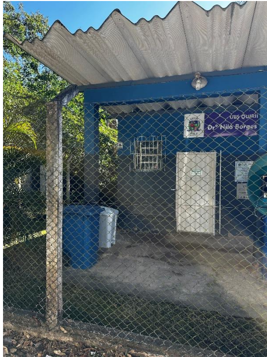
Figura 83: UBS do Quirino - Acondicionamento Externo.
