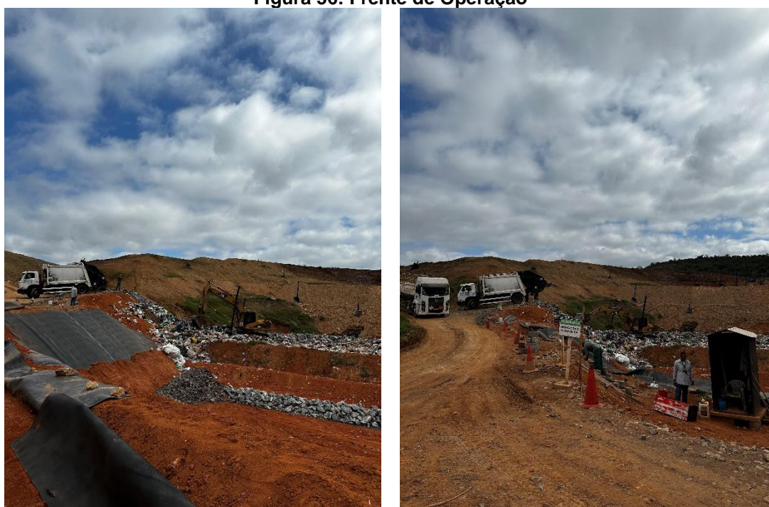
Figura 56: Frente de Operação
