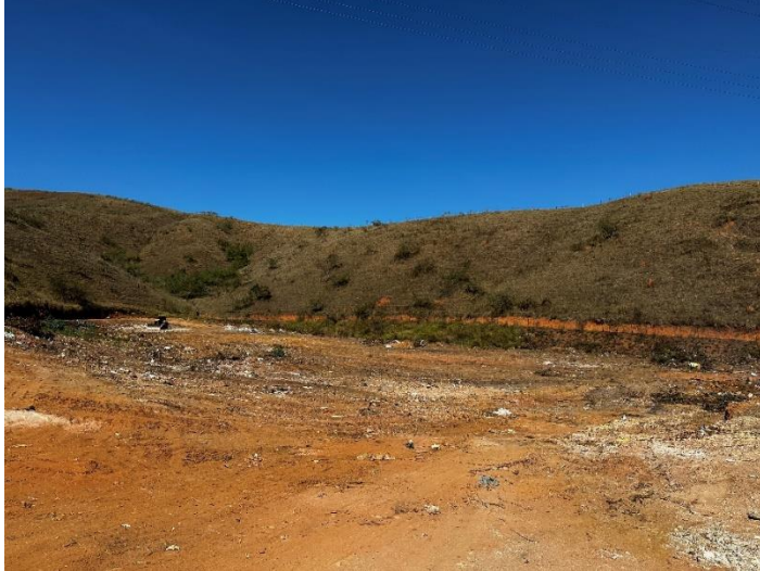
Figura 76: Vista Geral do Aterro de Inertes - Distrito de Pentagna
