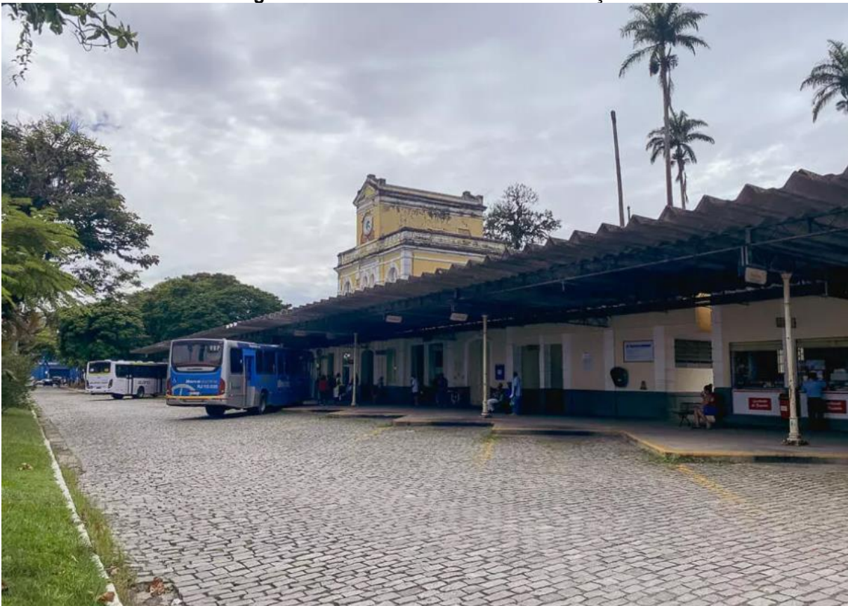
Figura 16: Terminal Rodoviário de Valença
