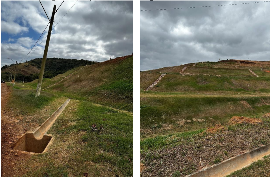
Figura 57: Dispositivos de Drenagem Pluvial dos Taludes
