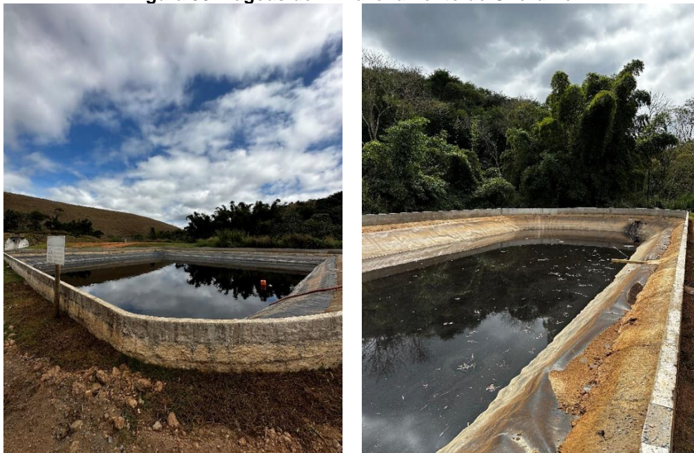
Figura 58: Lagoas de Armazenamento de Chorume
