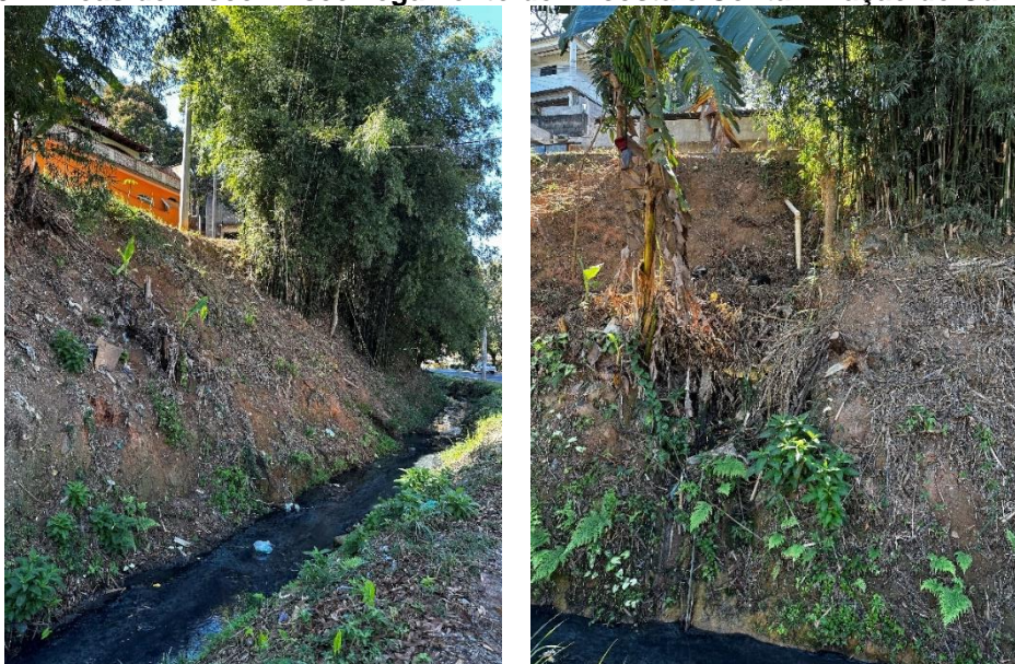
Figura 104: Áreas de Risco - Escorregamento de Encosta e Contaminação de Curso d'Água
