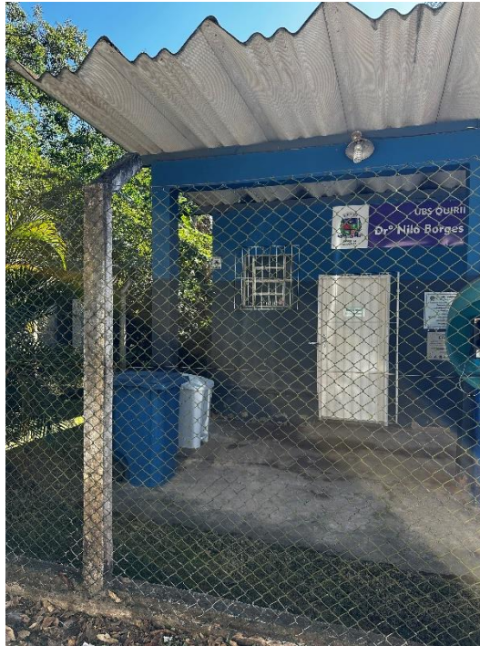
Figura 83: UBS do Quirino - Acondicionamento Externo.
