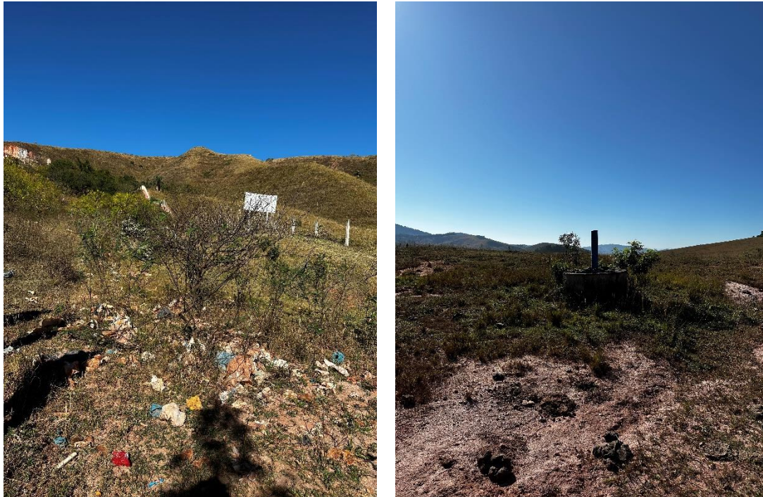
Figura 97: Resíduos Descobertos (esq.) e Chaminé de Gás (dir.) no Lixão Desativado do Quirino
