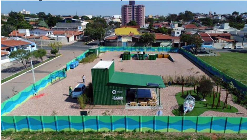
Figura 129: Modelo de ecoponto instalado em Salto/SP.
