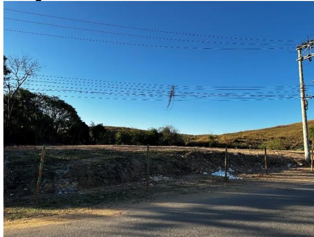
Figura 91: Vista Geral do Bota-fora Desativa.
