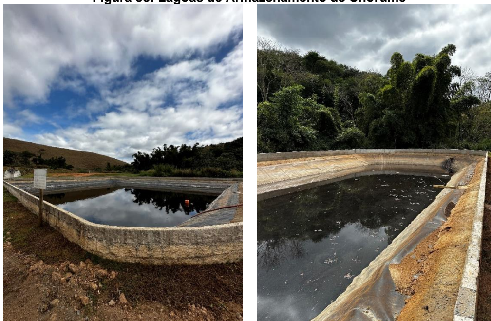
Figura 58: Lagoas de Armazenamento de Chorume
