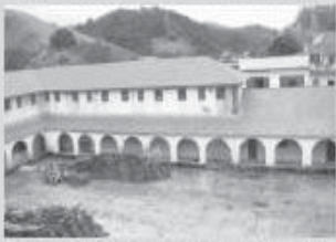
Reforma da Escola Maria Medianeira em Conservatória
